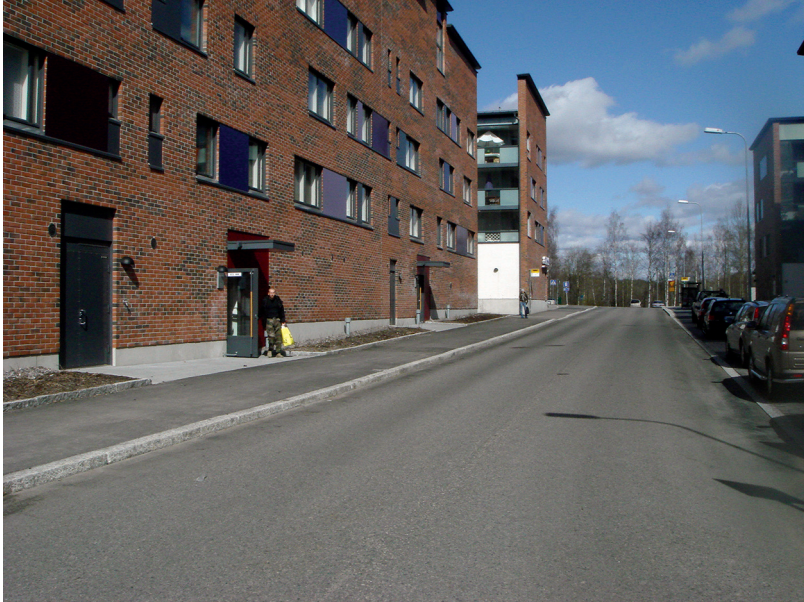
Kuva 8. Von Daehnkatua Latokartanossa. Rakennukset rajaavat katutilaa, jossa ensimmäisessä kerroksessa ei ole lainkaan ikkunoita. Valokuva: Karin Krokfors
